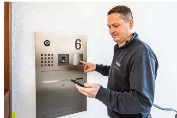
Elektroniker Miroslaw Koziol prüft den Türruf, der über die Siedle App auf dem Smartphone ankommt. Die Türstation ist im rechten Winkel zur Haustür verbaut.
