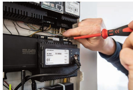
Die Schnittstelle Smart Gateway lässt sich dank des 6-Raster-Gehäuses platzsparend im Schaltschrank ergänzen.
