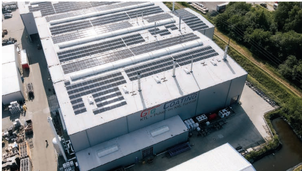
Bei mehreren Kunden von Greenflash ist die neu entwickelte, KI-basierte Software Greencore AI bereits im Einsatz und generiert massive Kosten- und CO 2 -Einsparungen. Das Bild zeigt das Energiesystem mit PV und Speicher der Unternehmen Giga Coating und System Trailers.
